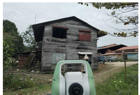
Replanteo de lotes urbanos
